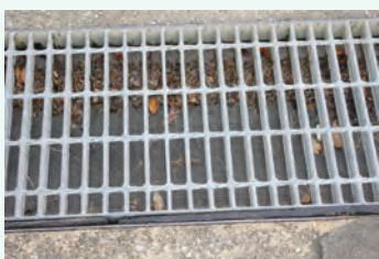
ネット取り付け後の排水溝
