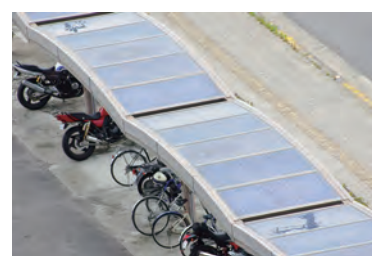
自転車置き場の屋根に設置 (林町キャンパス)
